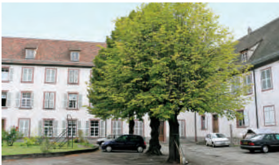
La cour et les bâtiments aujourd'hui.
