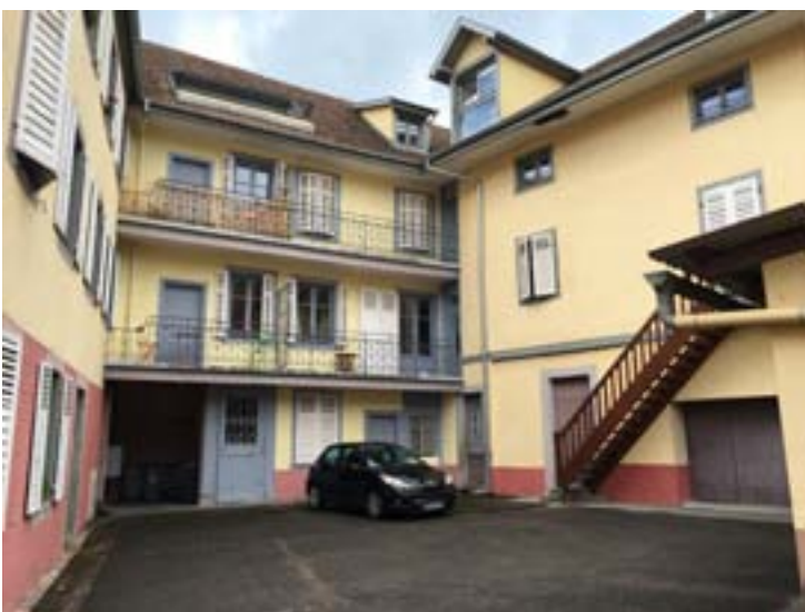
Emplacement de la première école supérieure de Ribeauvillé (Rue de la Fraternité)
